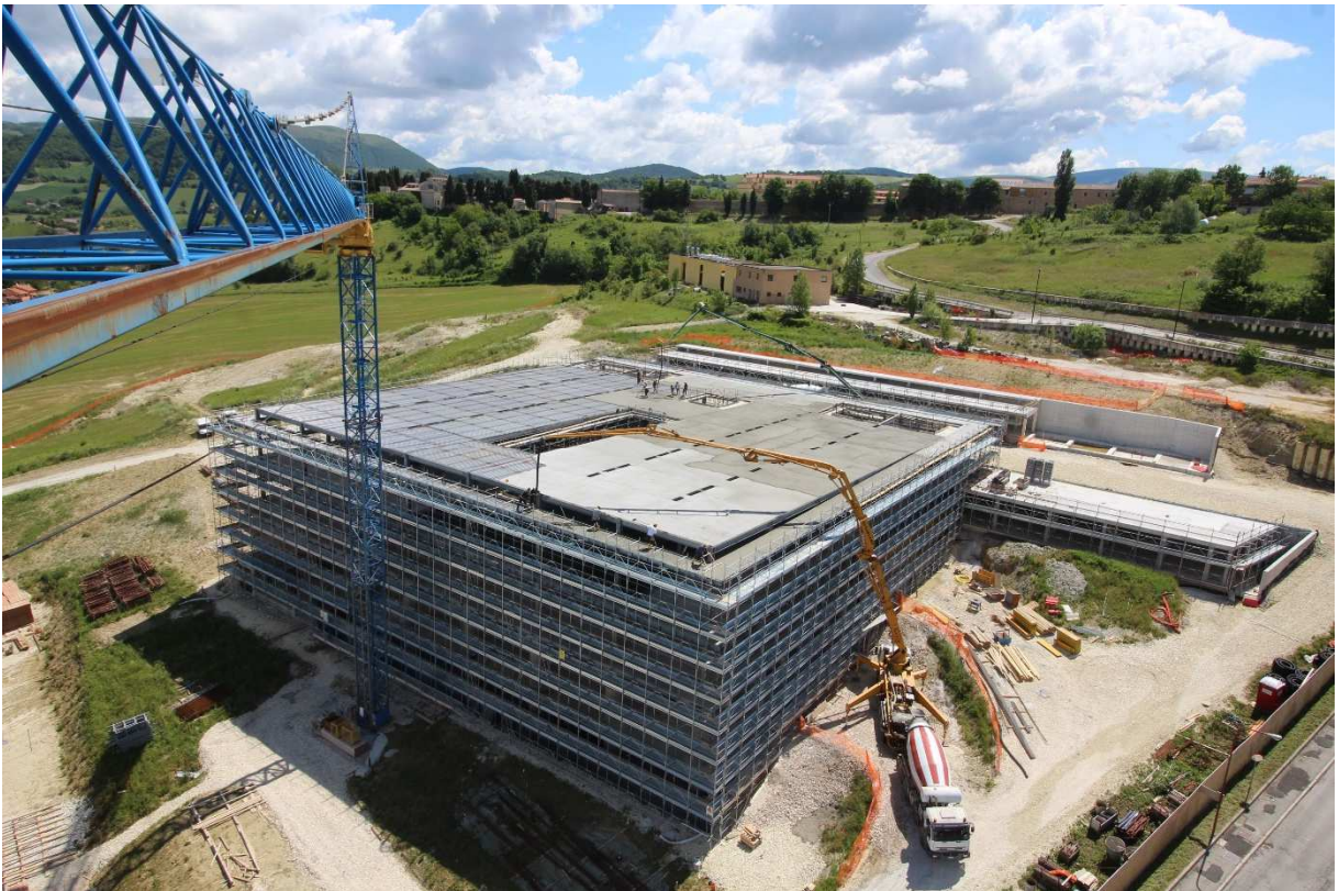
FOTO DEL CANTIERE
